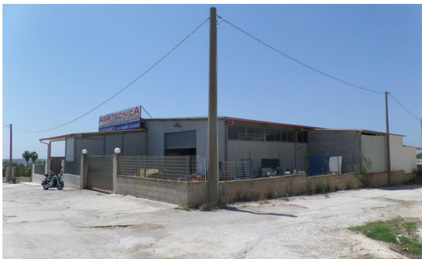
Foto n° 02. Rosolini. C.da Masicugno: Vista Nord
