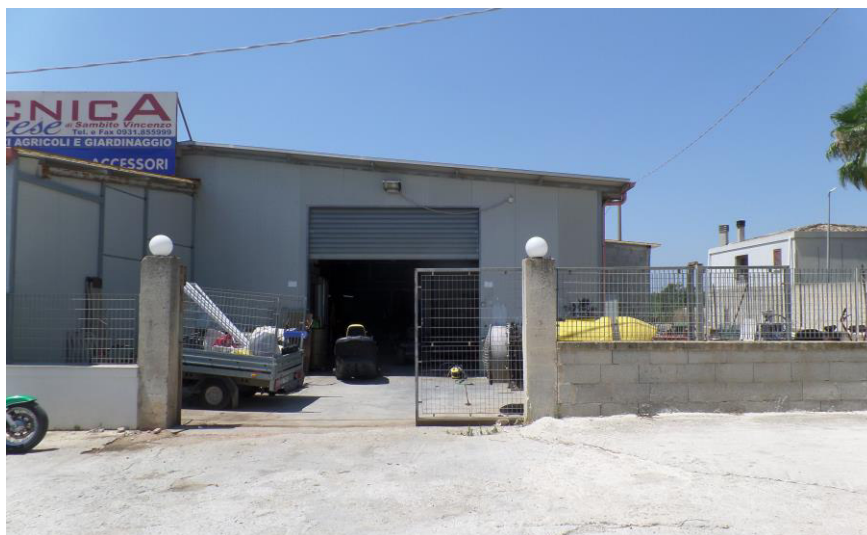
Foto n° 04. Rosolini. Prospetto Deposito (Vista Nord-Est)
